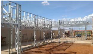
A palavra Steel indica a matéria prima usada na estrutura, o aço. A inclusão de Light, ou leve, indica que os elementos em aço são de baixo peso uma vez que são produzidos a partir de chapa de aço com espessura reduzida. Também ressalta a flexibilidade, dado que permite qualquer tipo de acabamento exterior e interior.
